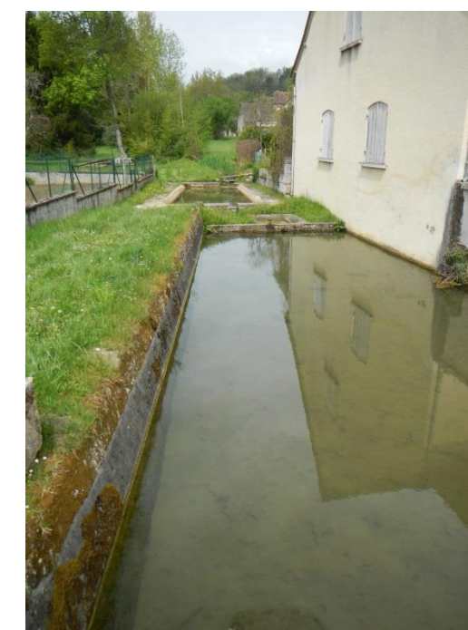
Photo 4 : Cours d'eau artificialisé dans le centre de Villars, traversant des lavoirs avant de s'écouler sous le centre-bourg
