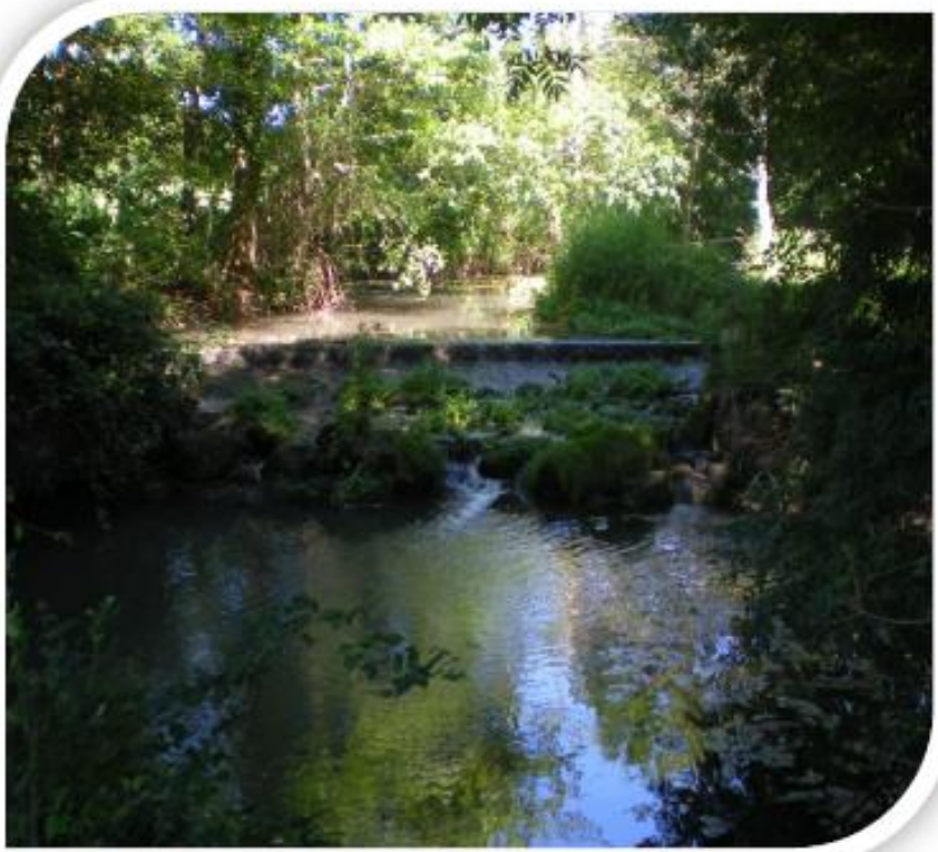
Ouvrage de répartition à l'origine du "canal des moulins" sur la commune de Gurat
