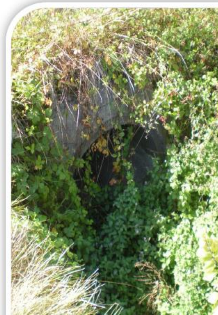
Présence d'ouvrage de type "buse" avec impact limité sur la continuité écologique
