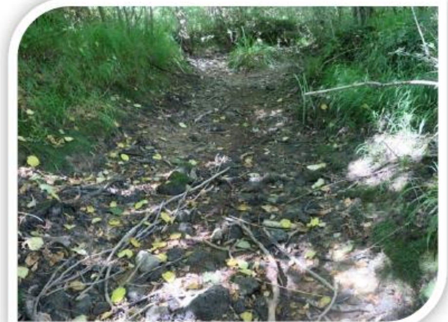
Secteur du lit naturel de la Nizonne court-circuité par la présence d'un ouvrage de répartition de moulin en mauvais état (moulin de Chanteranne)
