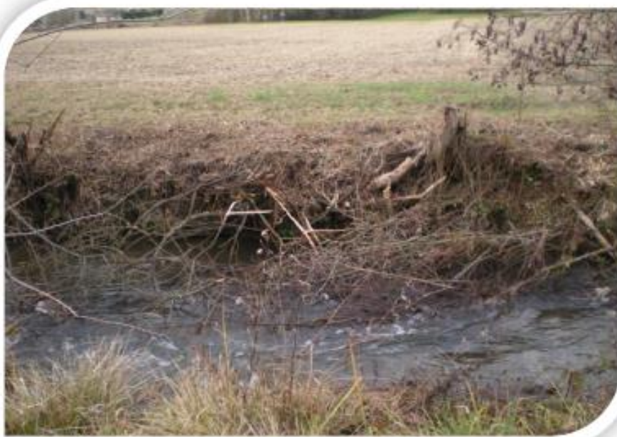
Gestion de la ripisylve inadaptée sur certaines portions
