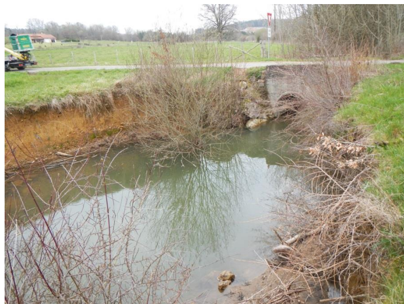
Photo 3 : Fosse de dissipation en aval d'un pont
