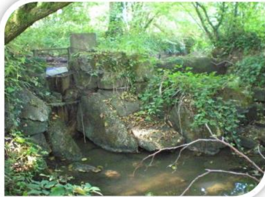
Déversoir du Moulin de Noailiac – Problème continuité écologique (sédimentaire et piscicole)
