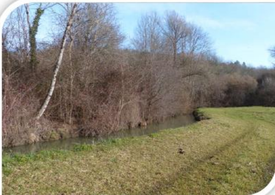
Portion sinueuse fortement recalibrée sous l'influence d'un ouvrage de répartition (Seuil du Moulin de Puylobard - commune de Beaussac)
