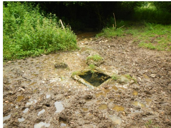
Photo 2 : Zone d'abreuvement latérale provoquant une dégradation des berges et un colmatage du lit mineur
