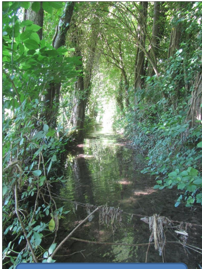
Profil historiquement redressé du Boulon (sans recalibrage)
