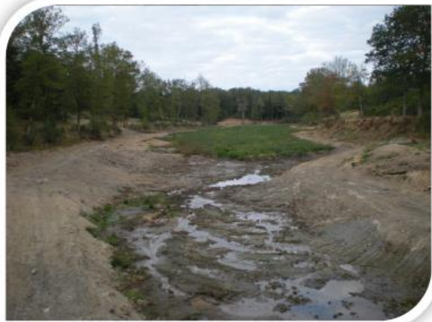
Impact de l'Etang rompu au niveau de la zone de source de la Belle (rupture de digue en 2008)
