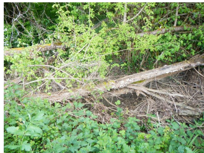
Photo 2 : Lit mineur encombré par du bois morts provoquant des embâcles.
