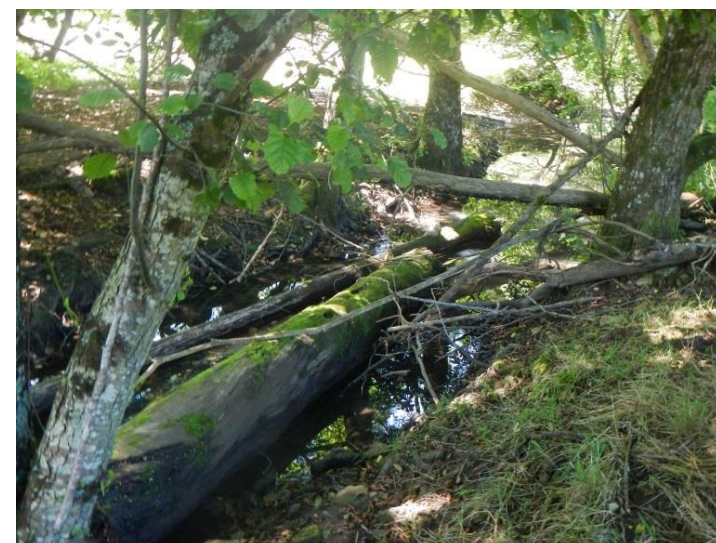
Photo 3 : Encombrement important du lit par du bois mort
