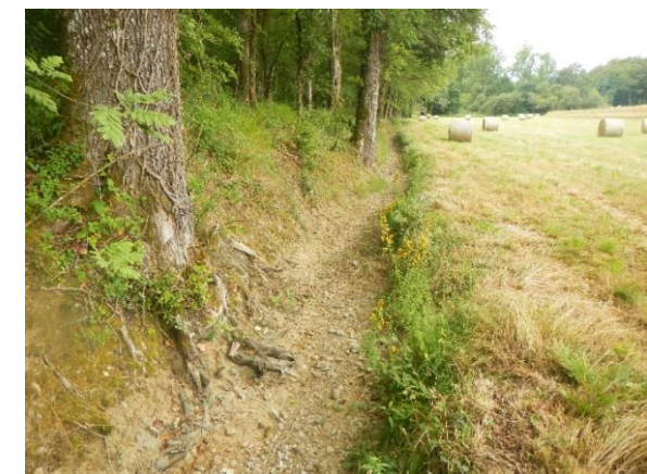
Photo 6 : Lit mineur rectiligne homogène ayant subi un curage sévère
