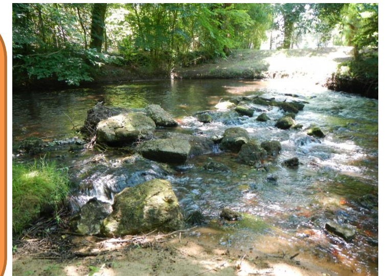
Photo 6 : Seuil en état de ruine. Retour des radiers sur la rivière
